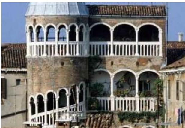
La torre, disegnata e costruita dall'architetto e carpentiere veneto *Giovanni Candi* nel 1499, è alta 26 metri e ha un diametro di 4,70 metri. E' formata da 80 gradini monolitici trapezoidali e si sale in senso antiorario. La scala da accesso ad attigue logge, sviluppate su quattro livelli superiori. La torre termina in un belvedere a cupola con ampia visuale sulla città. Originalmente la torre era adornata con affreschi.
