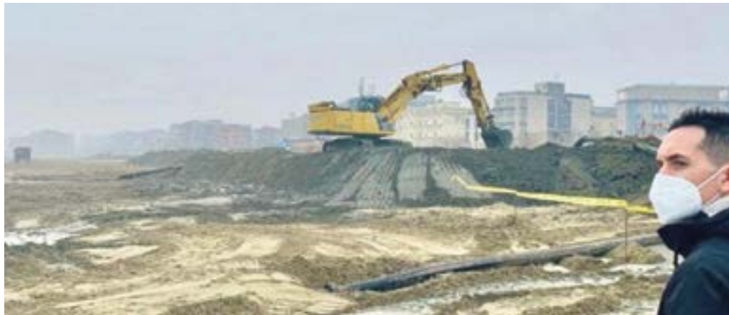
Il ripascimento 'allungherà' le spiagge, lavori h 24
