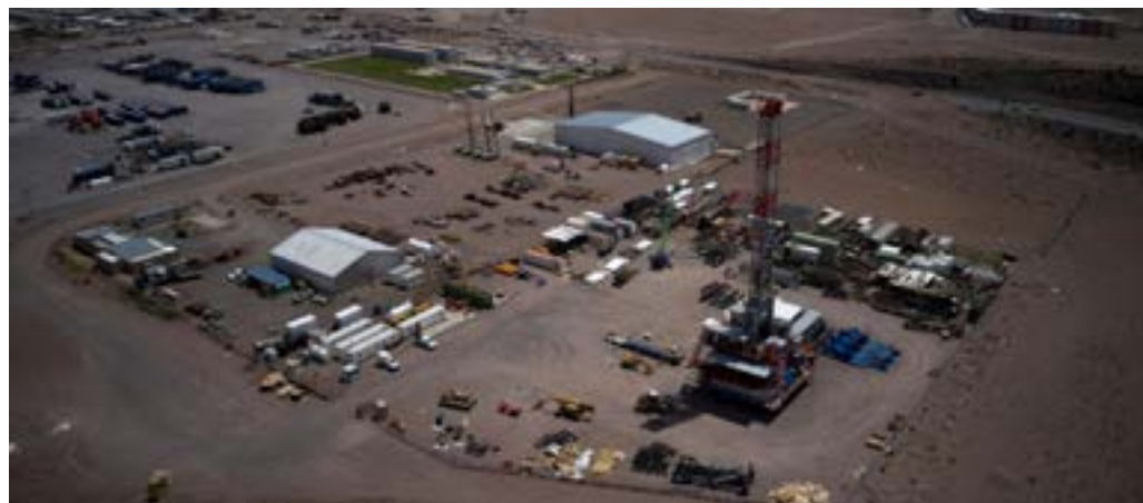
L'area dello stabilimento di "Vaca Muerta", in Argentina
